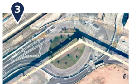
3 URBANITZACIÓ DE LA RONDA DEL PORT. TRAM IV (BUNGE). FASE 1
