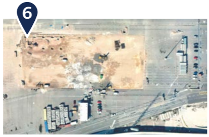
6 REBLERT DEL MOLL DE L'ESTACIÓ MARÍTIMA
