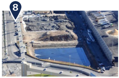
8 REPARACIÓ DEL SUBSÒL DEL MOLL CONTRADIC. FASE 2
