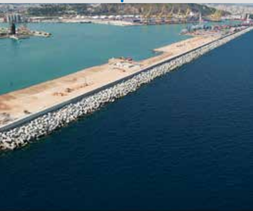
IMPROVING THE EST SEAWALL PHASE 4
