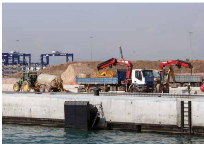
A finales del 2013 se empezó a ejecutar esta obra, que finalmente acabó en agosto del 2014. Ha tenido por objeto la construcción de la superestructura del muelle Prat sobre los cajones constitutivos del muro de muelle,
