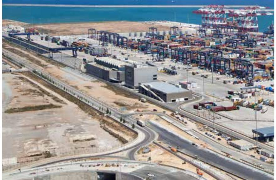
El objeto de esta obra es la creación de nuevos accesos a la ampliación sur del puerto de Barcelona. Concretamente, se ejecuta la red viaria del nudo sur de acceso a la ampliación sur. En el año 2012, con la fase 1A, ya se llevó a cabo el terraplenado y la precarga de la mayor parte de este nudo
