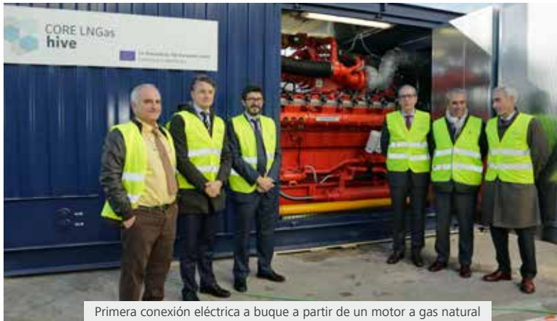
Primera conexión eléctrica a buque a partir de un motor a gas natural
