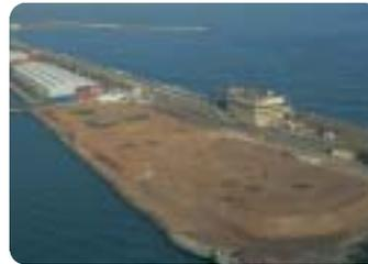
gat, de una longitud de 1.120 m, y la generación de una playa situada al sur de dicho espigón, mediante la aportación de un millón de metros cúbicos de arena.
